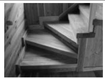
<現場集成の階段> 病害材利用の75 mm厚階段板
