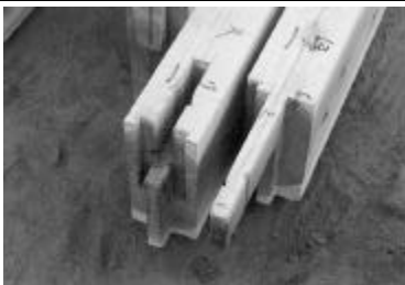
<伝統工法の住まいづくり> 金物は使わない伝統工法の継承
